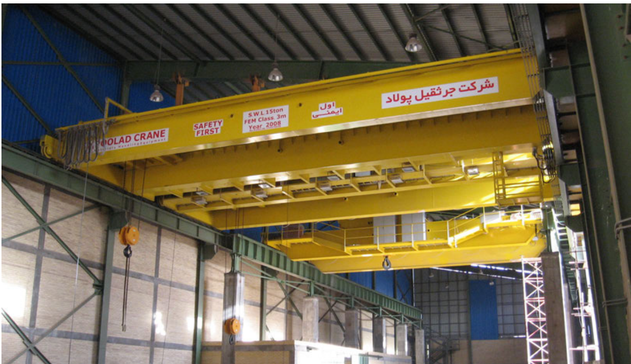
Roll Shop – Cranes 35/15 Ton
